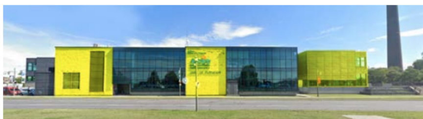
Bâtiment 1 - Usine d'épuration
