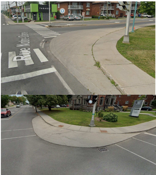
2.9 Intersection à rayon réduit avec partie franchissable
