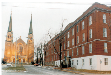
Site du patrimoine de l'Arrondissement institutionnel de la paroisse de Sainte-Cécile.
