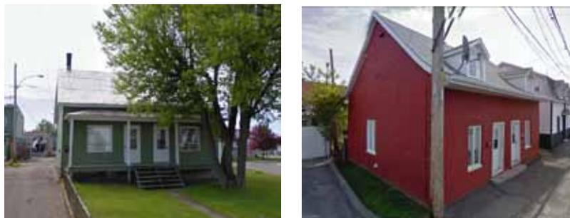
Figure 38 : Maisons de conception québécoise à deux logements avec des solages de différentes hauteurs. La présence d'un sous-sol exhaussé suggère une construction plus récente. À gauche : 6, rue Récollet. À droite : 26, rue Saint-Isidore. Source : Google Street View, 2010.
